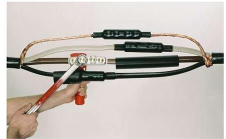
Die Leiterverbindung erfolgt mithilfe eines Schraubverbinders. Mit Knarre und Steckschlüssel wird die Schraube angezogen, bis sich der Abreißkopf löst.
