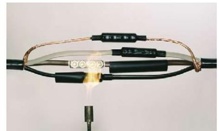
Die Schrumpfung der Isolierung erfolgt mittels Wärmezufuhr.
