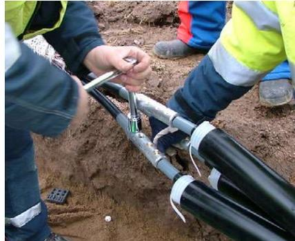
Das Anziehen der Schrauben erfolgt mit einer Knarre. Auch ein Akkuschrauber kann verwendet werden.
