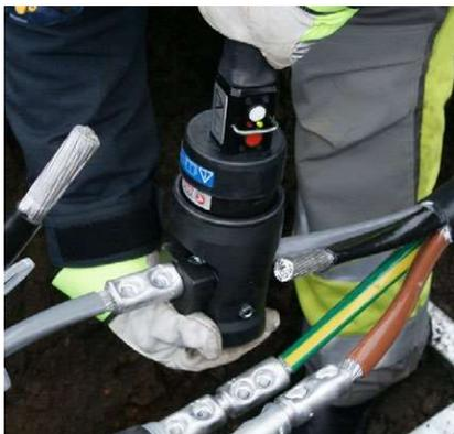
Dorn-Crimpen eines Elpress-Stoßverbinders mit Crimpkopf V250.
